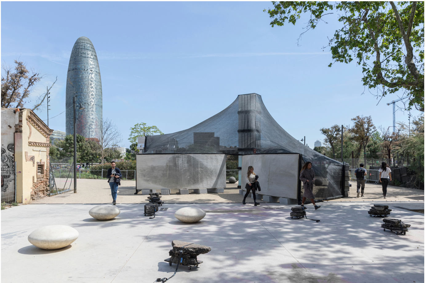
Der Pavillon in Barcelona besteht aus gefundenen Bau- und Abbruchmaterialien. Bild: Laurian Ghinitoiu
