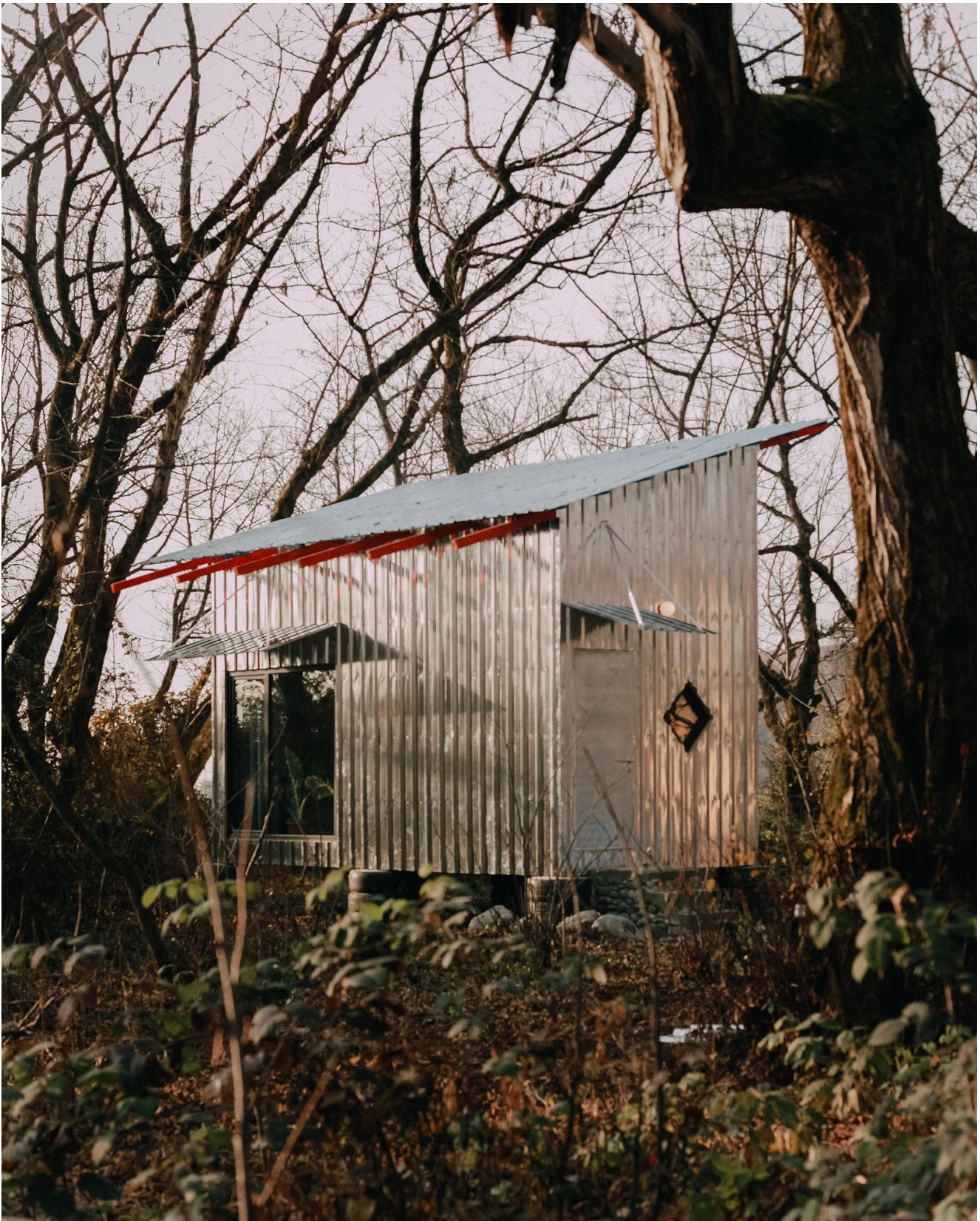
Das Blechhaus in Château Chapiteau war ursprünglich als Flüchtlingsunterkunft konzipiert und dient heute als minimale Wohneinheit. Bild: Kosmos
